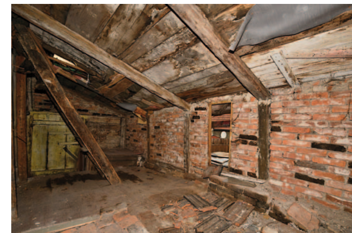
Interiér prostoru – m. č. 006 – z částečně hrázděného zdiva v ubourané části domu čp. 348 (Foto J. Koudelová, 2020)
