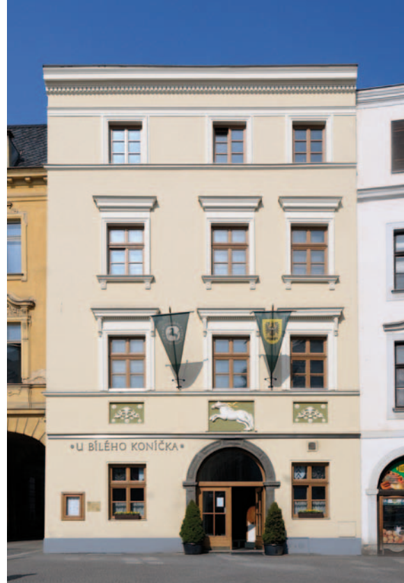
Celkový pohled na průčelí domu z Dolního náměstí po rekonstrukci fasády v roce 2005 (Foto Roman Polášek, 2011)
