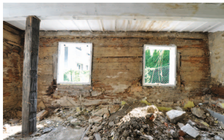
Pobled na jižní roubenou stěnu velké světnice – m. č. 003 – během demolice domu čp. 383 a její kresebná dokumentace. V kresbě jsou vyznačeny dendrochronologicky datované trámy, které byly zhotoveny z jedlí skácených v zimě 1785/1786. Horní trám datovaný po roce 1858 byl do roubené konstrukce vložen dodatečně v souvislosti s výměnou poškozeného prvku (Foto a zaměření D. Alterová, 2017, počítačové zpracování J. Dudek, 2019)
