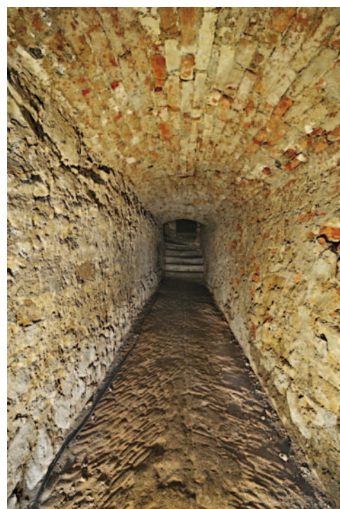
Pohled od východu do chodbičky vedoucí ze síně – m. č. 001 – do dvora domu čp. 38. Pochozí vrstvu tvoří precizně vyskládaná valounková dlažba (Foto D. Alterová, 2017)
