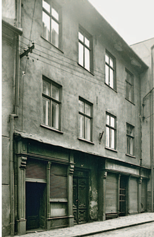
Pohled na uliční průčelí domu čp. 38 od severozápadu. Snímek z roku 1974 zachycuje dvojici skříňových výkladců v parteru objektu, odstraněných na začátku 90. let 20. století (Národní památkový ústav, územní odborné pracoviště v Ostravě, fotoarchiv, foto č. A 38317, Hlubínková, 1974)
