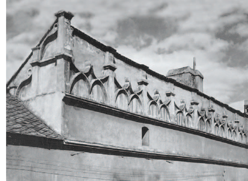
Detail horní části jižní fasády domu čp. 115. Na fotografii z 20. let 20. století je dobře patrné renesanční atikové polopatru završené atikou dělenou pilastry a mezi nimi dvojicemi proti sobě orientovaných cihlových slepých arkádek (SZM, uměleckohistorické pracoviště, Braunův archiv, inv. č. A 6429)
