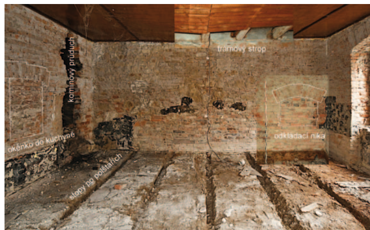
Pohled do hlavní světnice – m. č. 002 – domu čp. 348 od západu. Do snímku jsou vloženy výřez s odhaleným trámovým stropem a úsek začistěného zdiva s vyznačenou zazděnou odkládací nikou ve východní zdi, dále lze sledovat stopy po polštářích v zásypu prkenné podlahy, komínový průduch a zazděné okénko v severní zdi (Foto a zákres J. Koudelová, 2020–2021)
