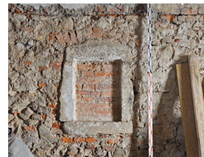
Zazděné okno určené kamenným ostěním se nachází v nynější společné obvodové zdi domů čp. 38 a 39. Původně osvětlovalo interiér objektu čp. 39 ze strany soutky (Foto D. Alterová, 2017)
