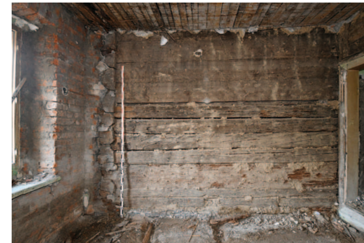
Interiér přední místnosti – někdejší komory – m. č. 004 – v ubourané části domu čp. 348. Roubená konstrukce byla identifikována až po odstranění omítek (Foto J. Koudelová, 2020)
