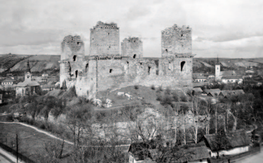
Zřícenina hradu Diósgyőr (Miskovec, Maďarsko), černobílá fotografie, pohled od jihu, 1933. Na první pohled je patrná pravidelná dispozice hradu s nárožními hranolovými věžemi (Dostupné z: https://fortepan.hu/en/photos/?id=6860 )
