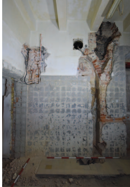
Dům čp. 115 – interiér přízemí zadního komorového dílu, renesanční cihlová zeď vylehčená slepou arkaturou, přiložená k původnímu středověkému kamennému zdivu (Foto F. Kolář, 2020)
