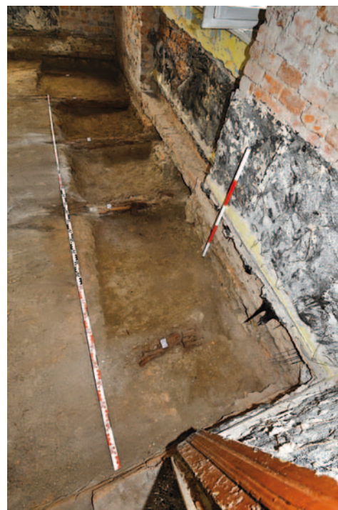
U západní zdi světnice – m. č. 002 – domu čp. 348 se podařilo odbalit všech pět polštářů druhé úrovně prkenné podlahy (Foto J. Koudelová, 2020)
