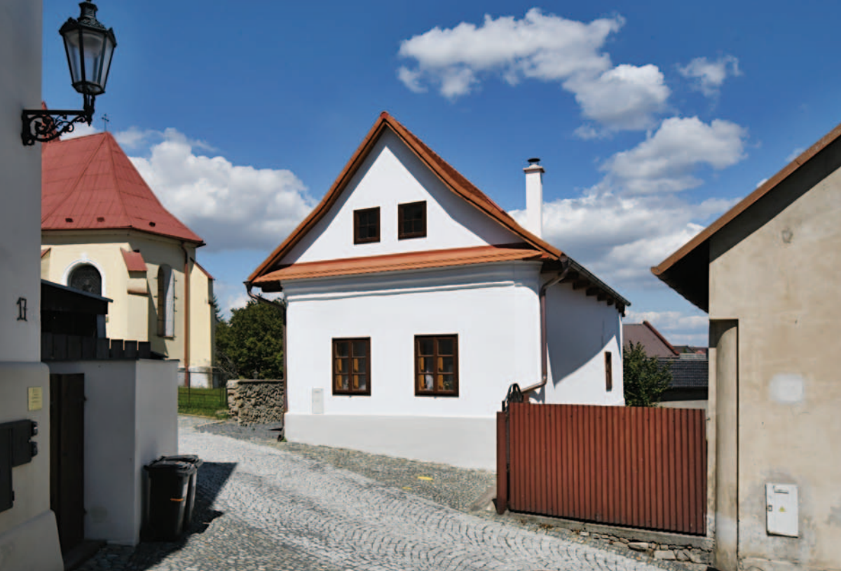
Celkový pohled na zrekonstruovaný dům čp. 348 od jibovýchodu (Foto J. Koudelová, 2022)
