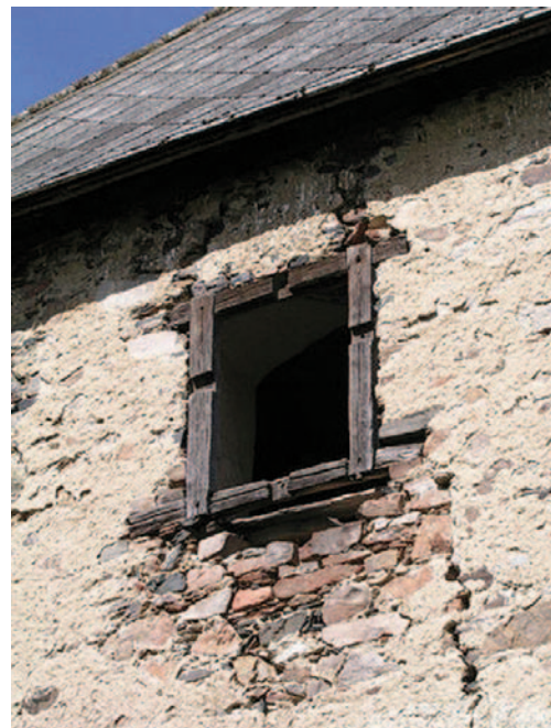
Dřevěná trámková zárubeň okna sálu ve druhém patře tvrze Sudkův Důl u Pacova z konce 15. století. Pro zapojení do kapes ve zdivu slouží přesabý parapetního trámku a překladu, dobře patrné plátové dlaby dokládají odstraněný masivní dělicí kříž (Převzato z: ŠKABRADA, Jiří. Konstrukce historických staveb. Praha: Argo, 2003, s. 337)
